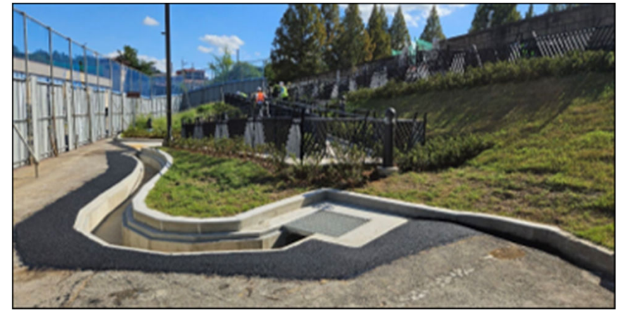
ADA Ramp & Stairs
